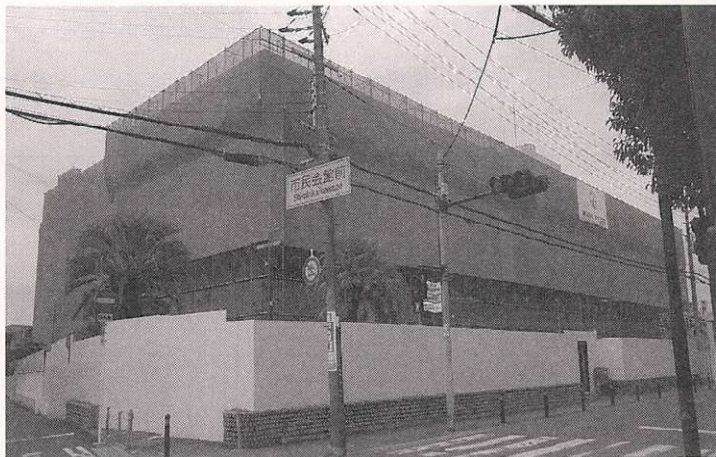
工事の完成も間近な市立市民会館
